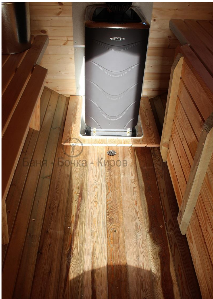
Фото отвода воды \varnothing 40 мм в местную канализацию.
