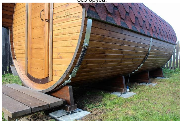
Фундамент на регулируемых опорах с площадкой с 2021 года без бруса.
